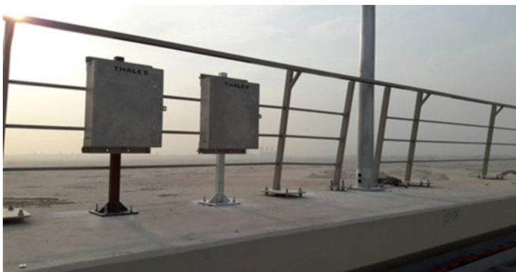
高铁道岔旁中使用了PCF不锈钢信号控制箱
